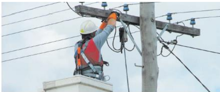
Рис. 6. Выполнять подключение к воздушной линии электропередачи имеет право только профессиональный электрик с необходимым уровнем допуска по электробезопасности.
